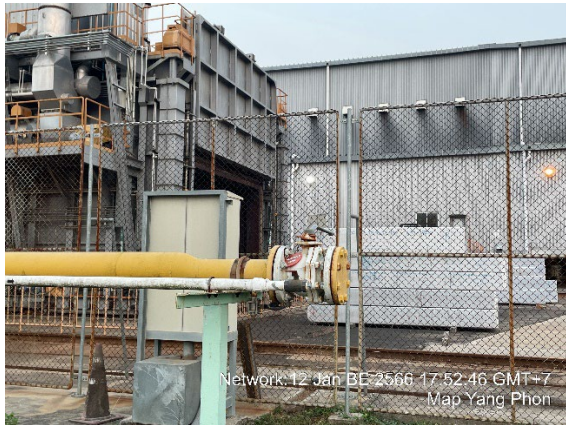
ภาพที่ 2-37 (ต่อ) Insulation Joint/Flang
