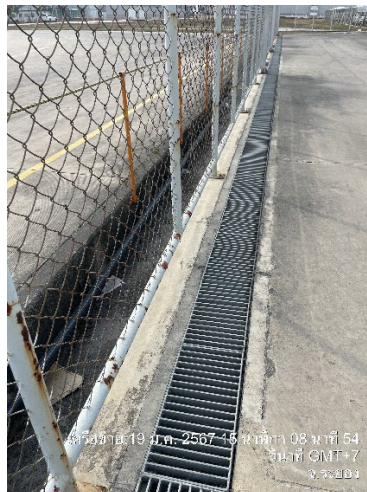
ภาพที่ 2-47 รางระบายน้ำและบ่อรวบรวมน้ำเสียบริเวณอาคารเก็บกากของเสีย
