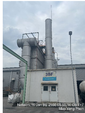
Bag Filter no.3 สำหรับนำอลูมิเนียมกลับมาใช้ใหม่
